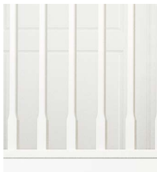
Montering i underliggeren
